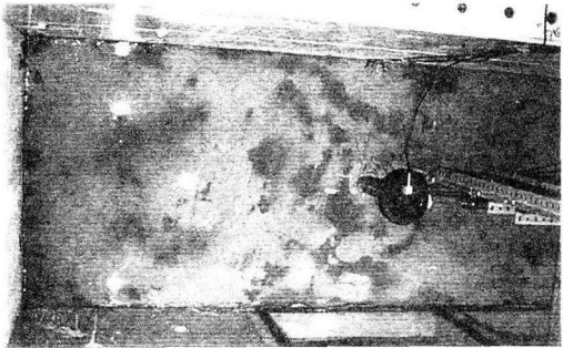
(a) 未改良部
