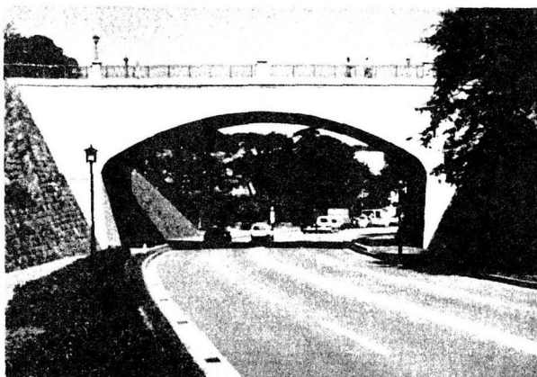
写真-9 架け替え後（石川橋）
