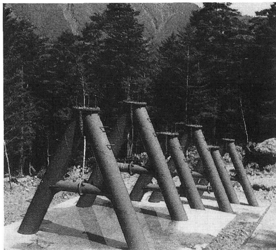
写真-1 A型スリットダム
