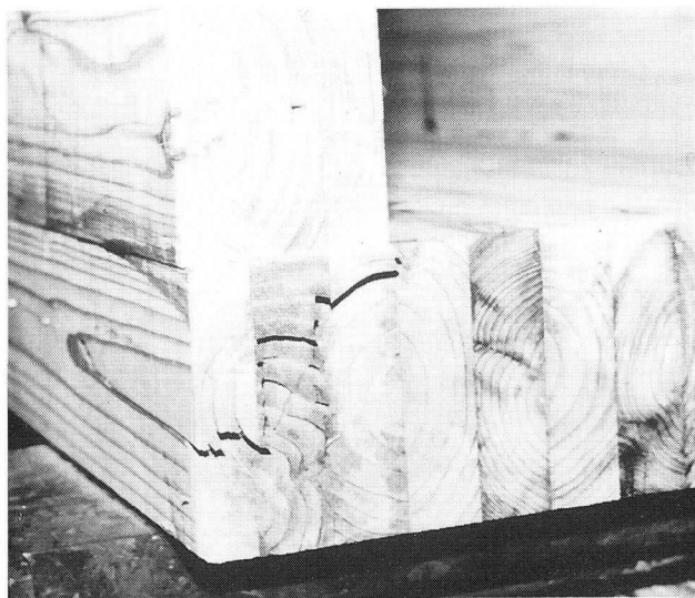
写真－1 せん断ひび割れ
