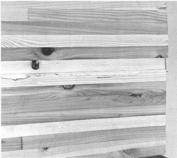
写真-2 せん断破壊 (ケース14)
