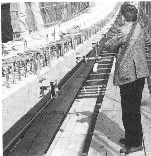
写真-1 サブワイヤの設置
