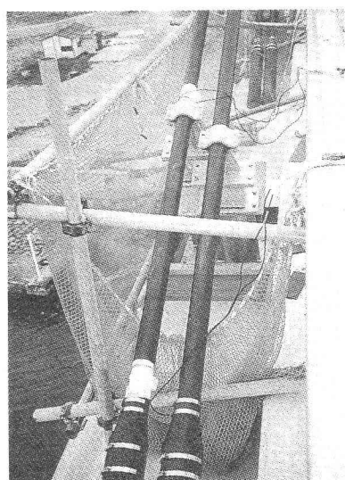
写真-2 S-22ケーブルでの実験状況
