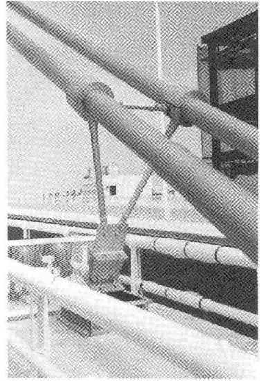
写真-1 青森ベイブリッジでの設置状況
