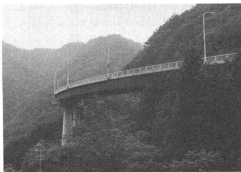
写真－４ ボルト継手部の見え方による曲線の強調例
