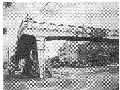
写真-4. 鋼ラーメン橋「八町歩道橋」 [B1]タイプ (撮影:91.6 増測)
