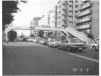
写真-1. 鋼ラーメン橋「笹原歩道橋」 [B3]タイプ (撮影:92.5 増測)
