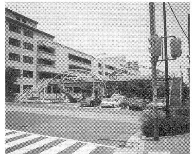
写真-3. 鋼アーチ橋「夕やけ歩道橋」 [D]タイプ (撮影:91.6 増測)
