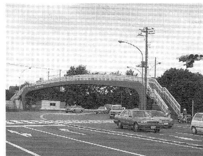
写真-8. 鋼ラーメン橋「禅馬歩道橋」 [B6]タイプ (撮影:90.8 増測)
