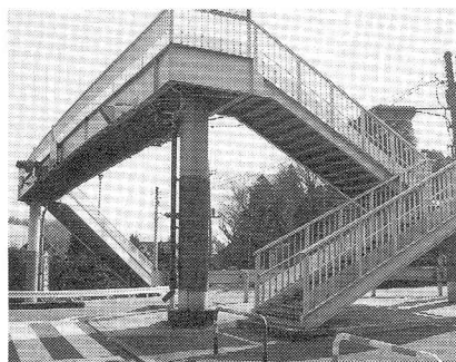
写真-5. 鋼桁橋「長津田第4歩道橋」 [A3]タイプ標準形式 (撮影:91.2 増測)
