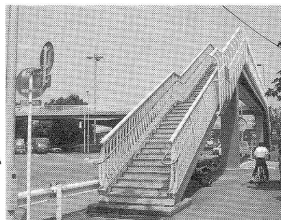
写真-6. 鋼ラーメン橋「蓮根歩道橋」 [B8b]タイプ (撮影:90.8 増測)
