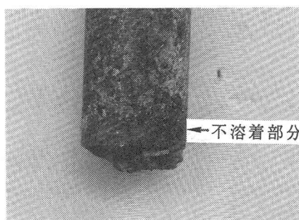
写真2 スタッド幹部の不溶着状況
