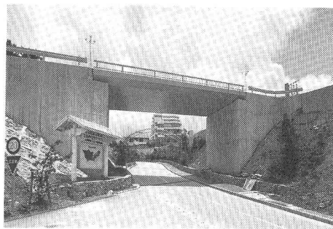
写真-5 かりゆし橋竣工写真
