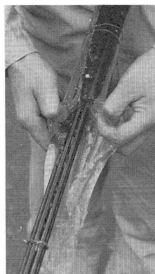
写真-8 ポリウレタン充填した健全なケーブル
