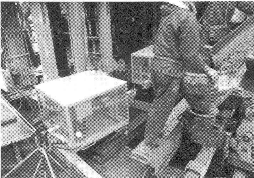
写真-3 コンクリート打設天端自動測定装置
