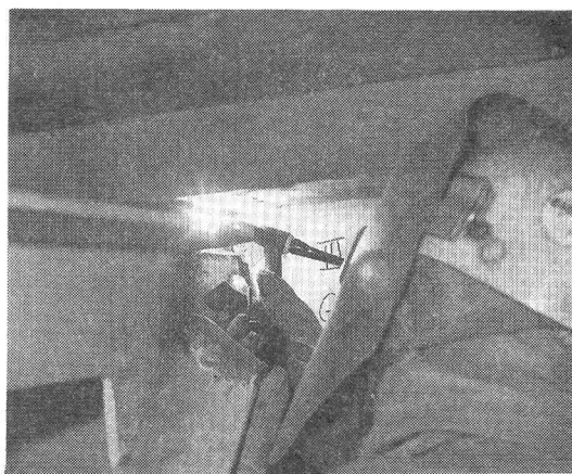
写真-2 実橋での試験施工状況
