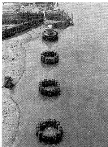
写真-1 鋼管矢打込完了状況
