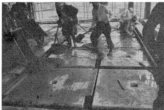
写真8 小ばりのコンクリート打込み
