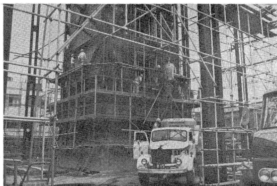
写真 4 スライディングフォームによるコアのコンクリート打ち込み
