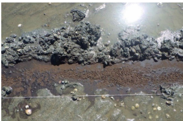
写真 2 浅溝投入砂被覆法
