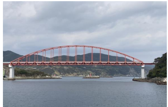
図 1 樺島大橋の外観
