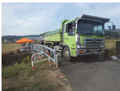
写真1 載荷試験の状況
