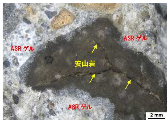
写真-4 粗骨材内に生じたひびわれとアルカリシリカゲルの滲出状況 (A2 橋台)
