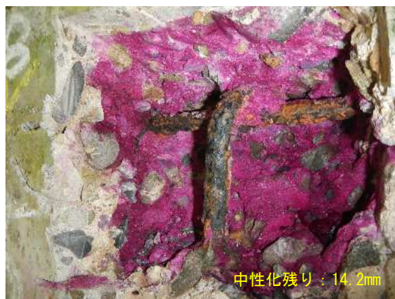
写真-3 はつり調査及び中性化試験実施箇所 (A1 橋台)
