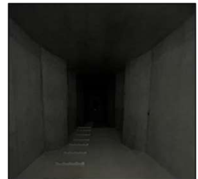
写真1 箱桁内部の様子
