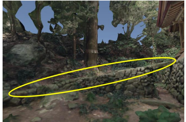
図-3 写真測量で生成した傾斜
