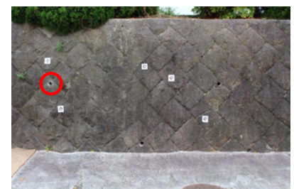
写真-2 対象の擁壁
