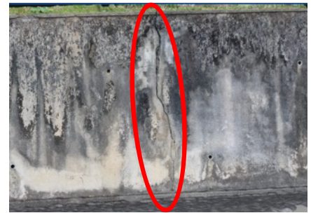
写真-4 縦クラック画像処理結果
