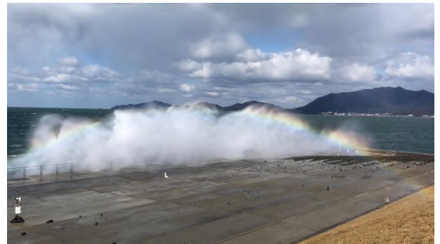
写真-1 直立護岸での越波の例
