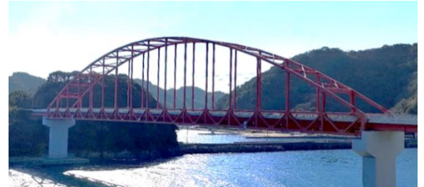
図 1 A 橋の外観
