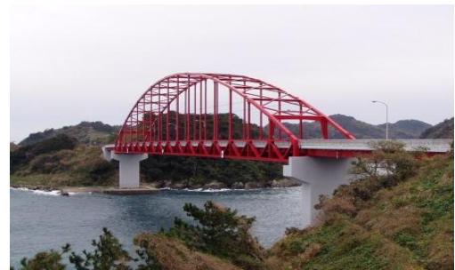
図-1 樺島大橋の外観
