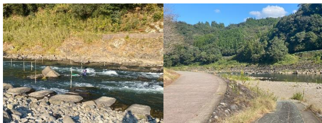
図-7 左：大野川，右：アクセス施設 W=32m , H=5.0m , \phi=1:4.0 , COD=2.0
