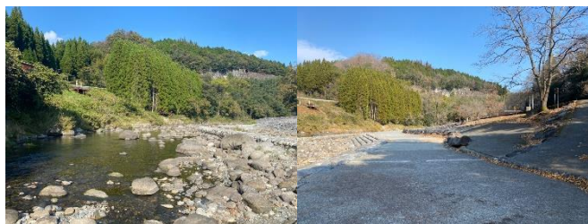
図-6 左：奥岳川，右：アクセス施設 W=34m , H=4.5m , \phi=1:3.0 , COD=2.0
