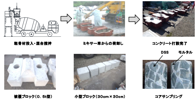
写真-2 DS ブロック製作状況
