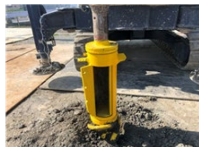
写真-1 改良土の採取装置
