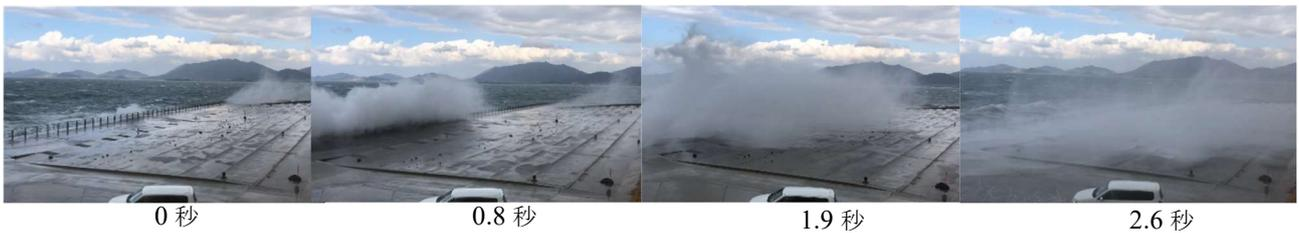
写真-6 大規模越波の発生と越波飛沫の様子
