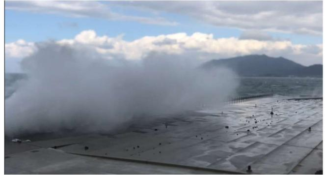
写真-1 直立護岸での越波の例
