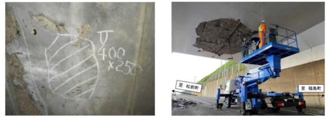
写真1 うきの損傷
