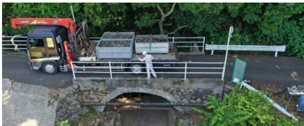
写真-3 静的載荷試験状況（左岸→右岸）
