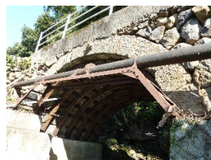
写真-1 下流側側面
