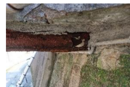
(b) 欠損(主桁)
