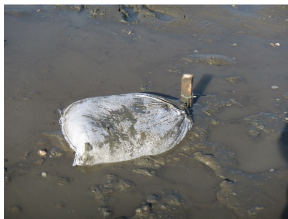
写真 1 干潟に施工したフルボ酸鉄シリカ資材
