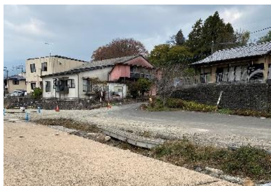
図-4 ①高水敷の状況
