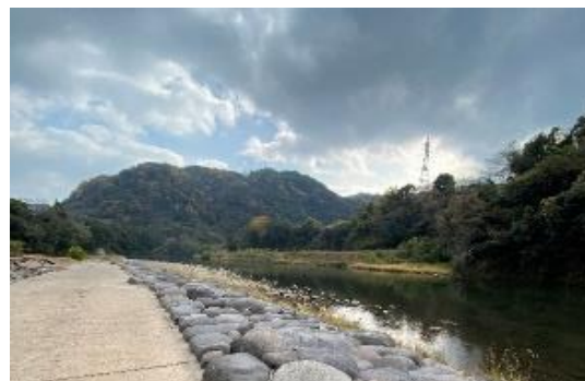
図-3 ①護岸構造
