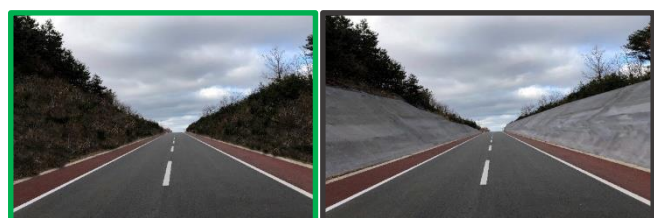
図5 道路切土法面比較写真
