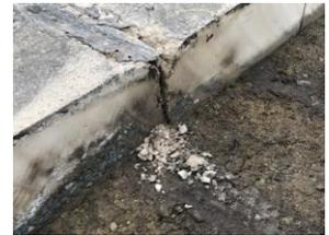
写真-1 雨水浸透による舗装劣化後の路盤の状況
