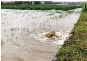
図-1 パイピング(筑後川 38k600 右岸)
