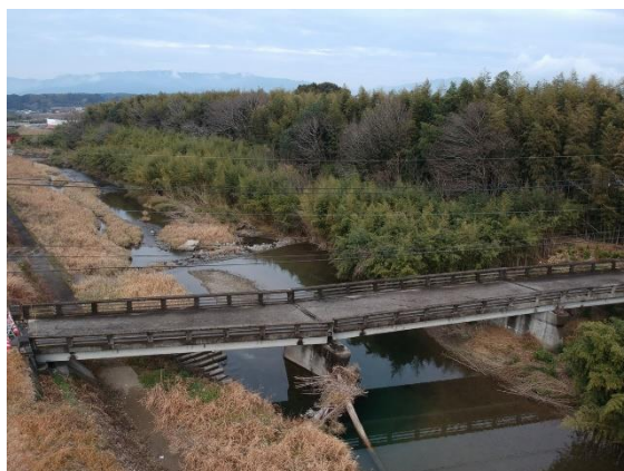
図5 水無川橋(錦町)
