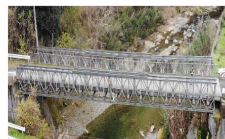
写真 2 対象橋梁 B
