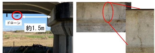
図-4 橋脚実ひび割れ確認状況
