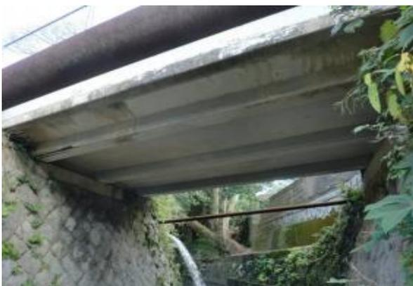
写真-1 A橋の橋桁損傷状況
