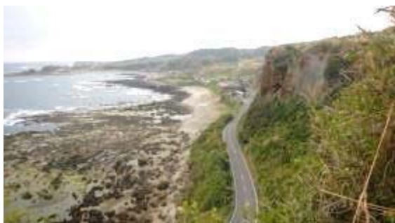
写真1 落石対策が必要とされる路線の概況
