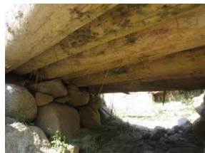
写真-2 下から見た仮設木橋
