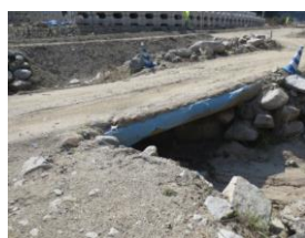
写真-1 仮設木橋の例
