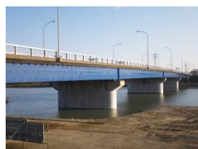
(a) 河川横過橋梁
