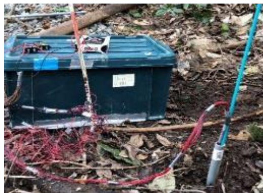
図7 地下水位計設置の様子
