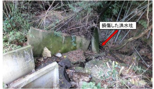
写真2 西分第1ため池の損傷した洪水吐
