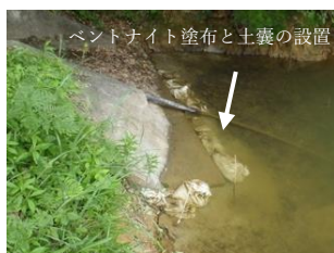
図 2.2 止水対策(水土里ネット島根資料)
