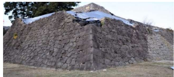
写真-2 飯田丸五階櫓石垣(左: 西面, 右: 南面)
