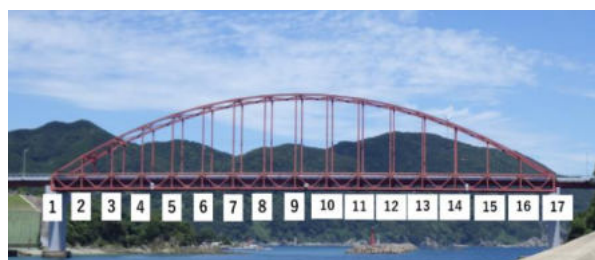
図 2 樺島大橋外観
